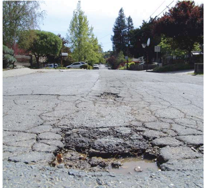
Camino Colorados, Lafayette
