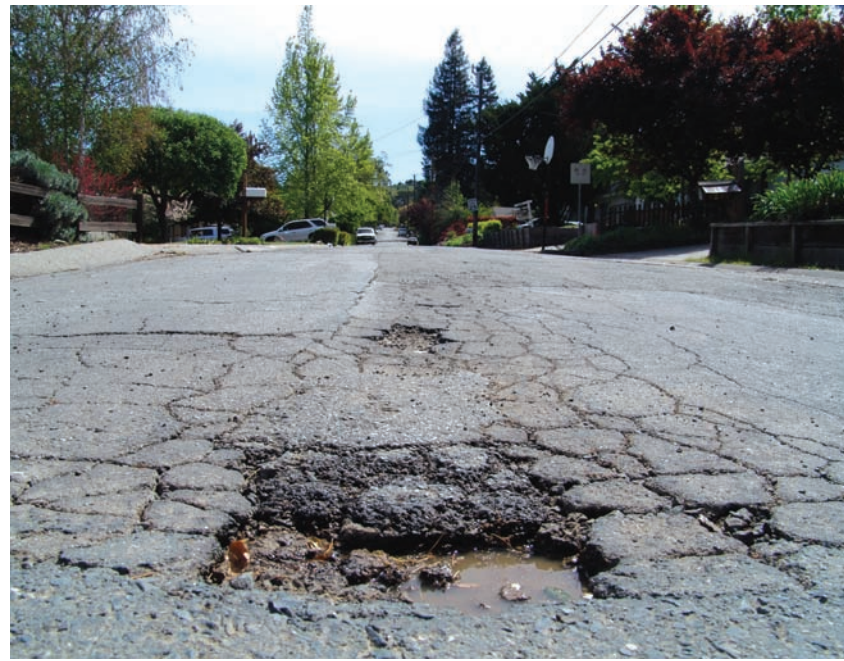
Camino Colorados, Lafayette
