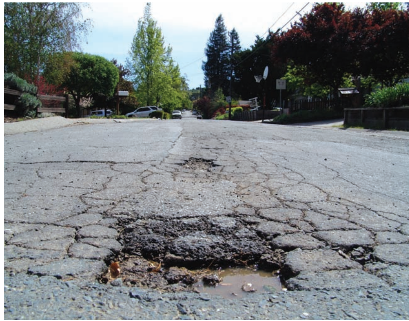
Camino Colorados, Lafayette
