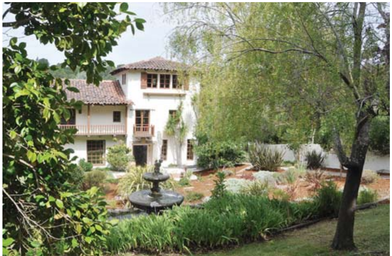
View of the front of the Casa del Sueño.
